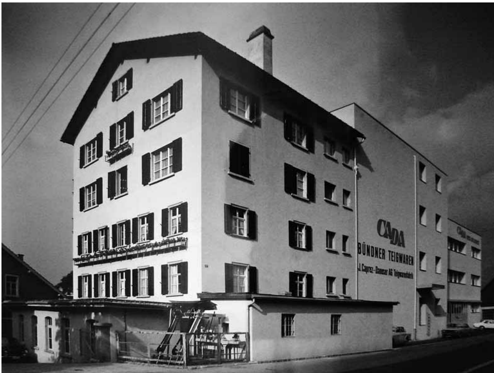
Abb. 127: Chur, Sägenstrasse, Kraftwerk CaDa, Nr. 2-257. Die Teigwarenfabrik CaDa mit dem Kleinkraftwerk, Aufnahme aus den 1970er-Jahren.
