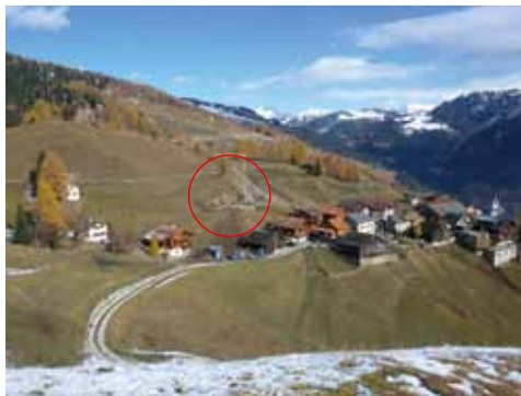
Abb. 11: Casti-Wergenstein, Wergenstein, Niersura 2009. Die Fundstelle der Gräber auf dem Baugelände von Niersura (Kreis). Am rechten Bildrand ist die evangelisch-reformierte Kirche (St. Calixtus) zu erkennen. Blick gegen Nordosten.
