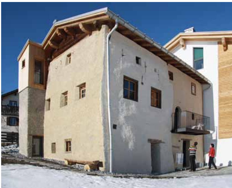
Abb. 139: Lantsch/Lenz, Haus Willi, Nr. 90. Ansicht von Südwesten, Nachzustand.
