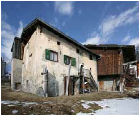
Abb. 140: Lantsch/Lenz, Haus Willi, Nr. 90. Ansicht von Südwesten mit der nordöstlich angebauten, heute abgerissenen Stallscheune, Vorzustand 2008.
