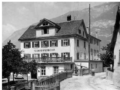
Abb. 126: Chur, Sägenstrasse, Kraftwerk CaDa, Nr. 2-257. Die Teigwarenfabrik CaDa mit dem Kleinkraftwerk, Aufnahme um 1910.
