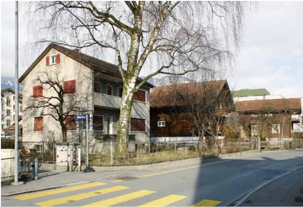
Abb. 169: Igis, Landquart, Abbrüche im Raum Bahnhofstrasse. Die Wohnhäuser Nr. 311, 312 und 312A an der Zollstrasse vor dem Abriss. Ansicht von Südwesten.
