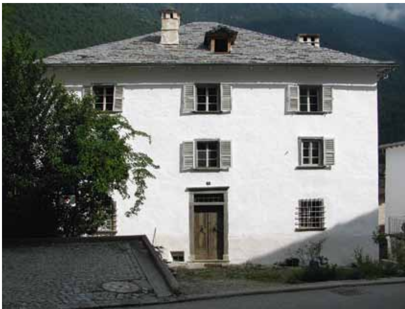
Abb. 143: Mesocco, Casa a Marca di Sotto, Nr. 89. Ansicht von Westen.
